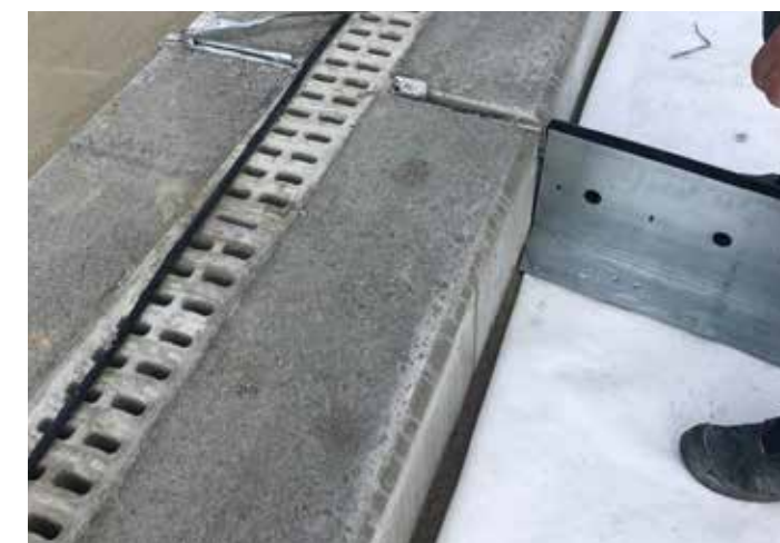
MONTERING: Betonggjutning av ytvattenränna
